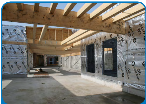
Les travaux d'extension de l'école Joliot Curie avancent à grands pas
