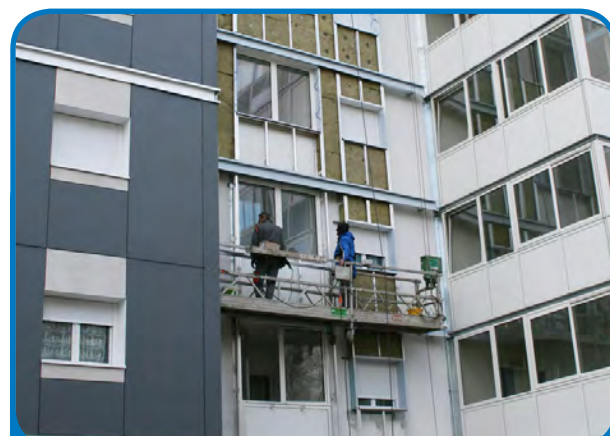
L'isolation de l'immeuble des Chardonnerets améliorée
