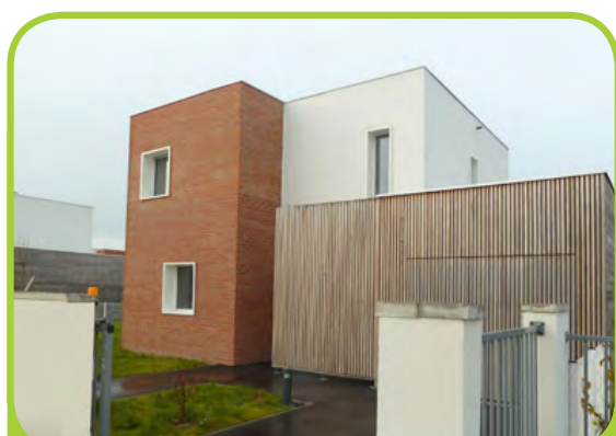
Les Maisons Basse Consommation de la Foncière Logement - Résidence Mallet
