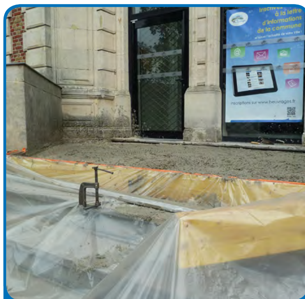
Isolation du Péron de l'Hôtel de Ville - 24 septembre 2013 -
