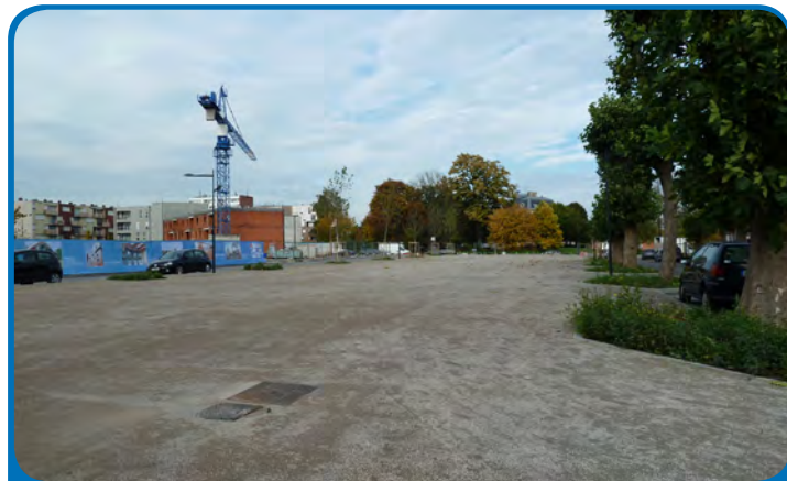
La place Hector Rousseau en cours de rénovation - Octobre 2013 -
