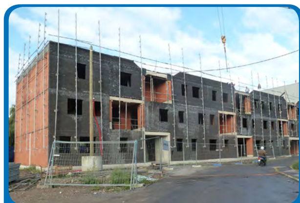
La construction des futurs appartements avance à grands pas - octobre 2013
