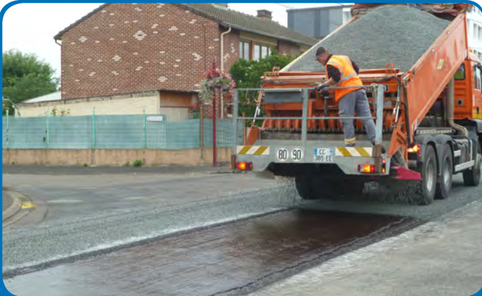
Nouveau revêtement de surface pour la rue Maurice Thorez - Septembre 2013 -
