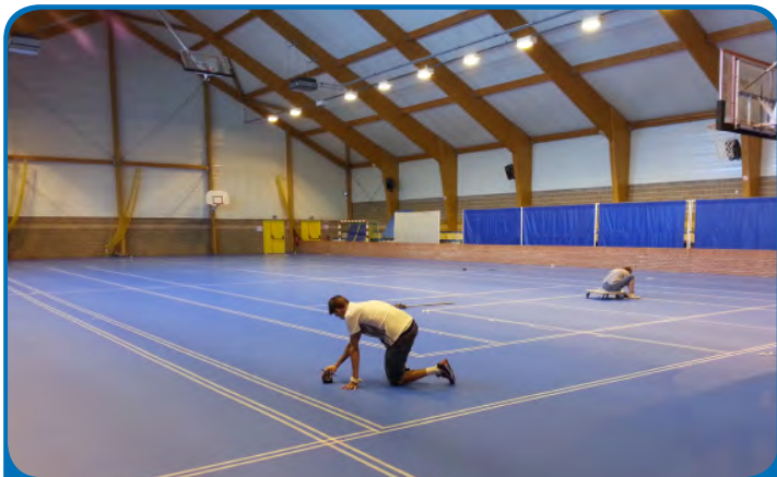
Un nouveau sol sportif pour la salle Léo Lagrange - Août 2013 -
