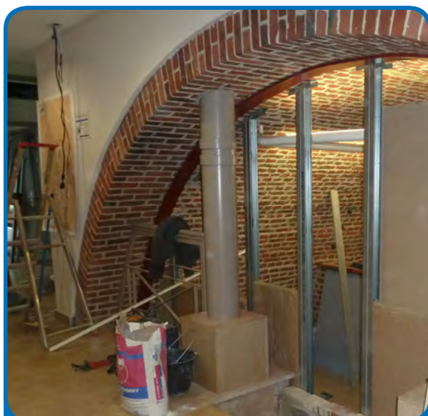
Séparation de locaux pour créer de nouveaux bureaux
