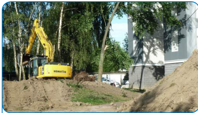
Les travaux de terrassement ont marqué le début du chantier
