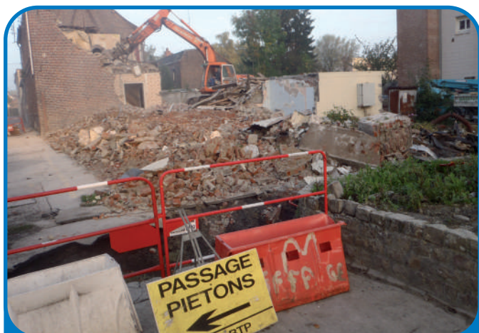
La Salle Fourret démolie .... place aux premiers aménagements de la Médiathèque et de la Maison de la Petite Enfance
