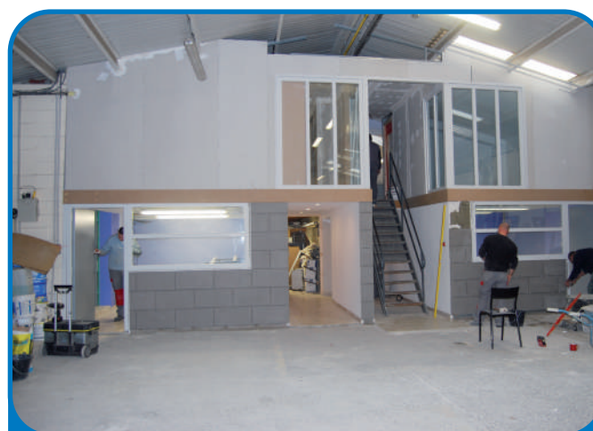
Agrandissement des locaux du Centre Technique Municipal, par les agents communaux
