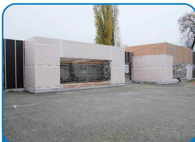
Suite à l'abandon du chantier par une entreprise, les travaux d'extension de l'école de Joliot Curie ont repris : fin prévisionnelle du chantier à l'été 2013
